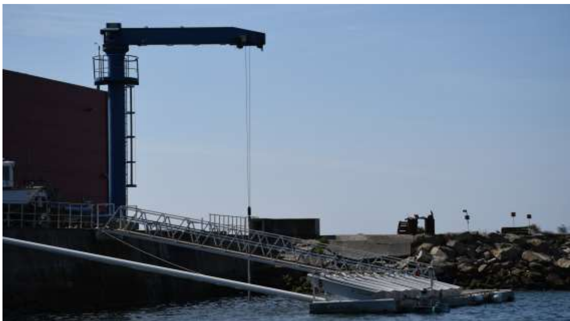
Figure 5 - Crane and Pier of Clube de Vela de Viana do Castelo
